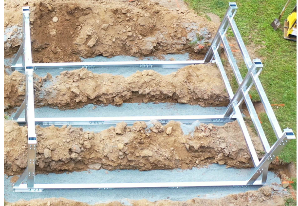
Montierte und in Waage ausgerichtete Konstruktion im Graben
