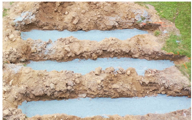
Gräben: Der Splittunterbau ist waagrecht auf Fertighöhe
